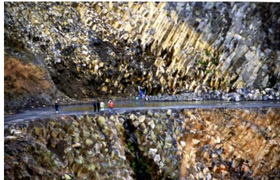
写真② 岩盤亀裂から湧水が多い
